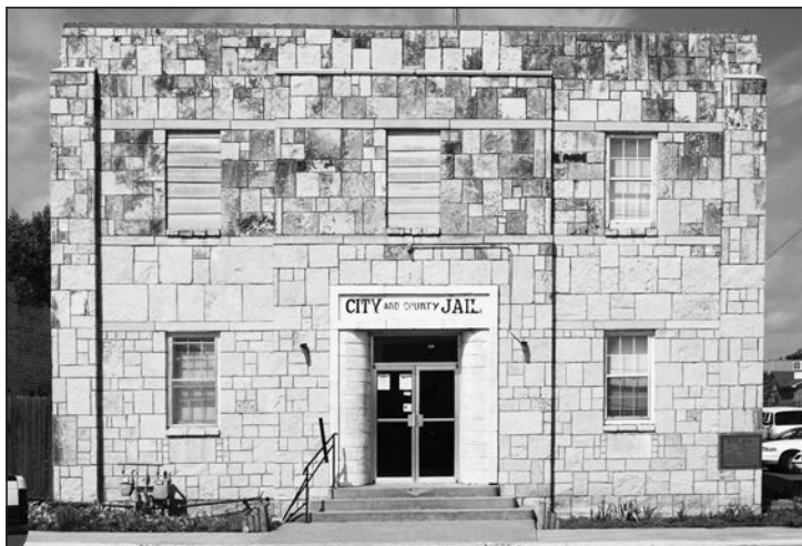
Hollis City Hall and Jail (J. Gabbert/SHPO photo).
